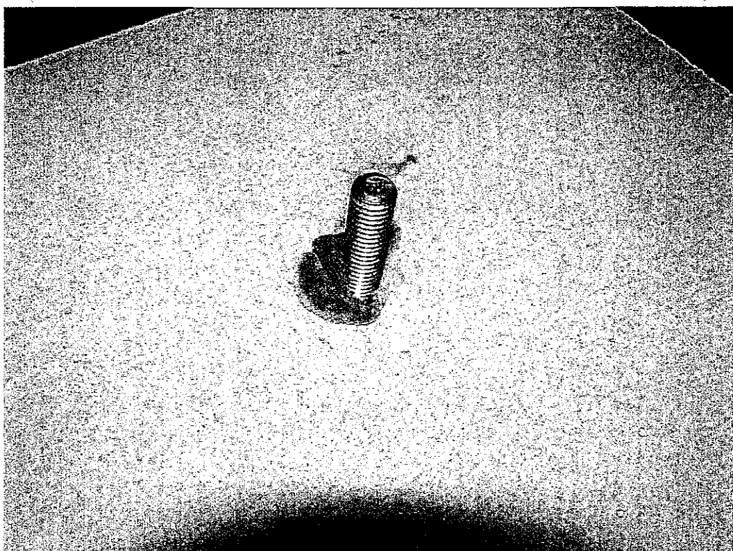
Рис.50. а) Химические анкеры фирмы «SORMAT» после установки в газобетонный блок: а) КВТ 8+ ГН 380 8×140; б) ГН 380 8×140.
